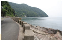
亀山の南に続く自然海岸。道路のところどころに駐車スペースがある
